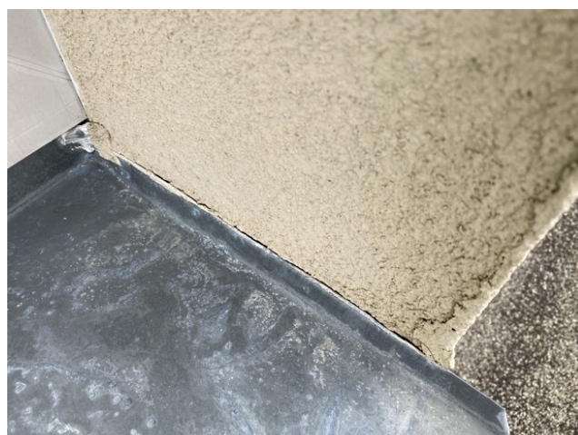
foto/44/ Pohled na osazení venkovního parapetu v místě krajního pavilonu (absence zapuštění parapetu do ostění)
