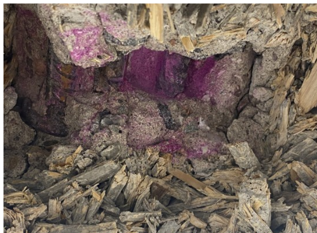
foto/6/ Pohled na obnaženou výztuž v místě sekané sondy žebírka T2 a na míru karbonatce (cca 20 mm)
