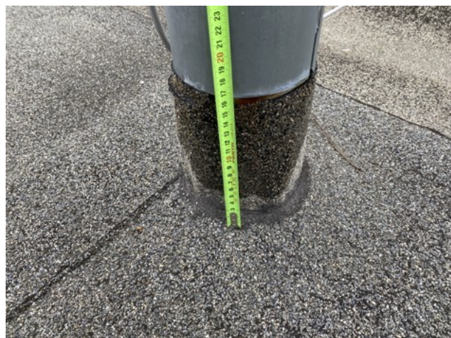
foto/54/ Pohled na opravu a vytažení HI vrstvy na větrací potrubí (vytažení HI cca 160 mm, absence stahovací objímky)
