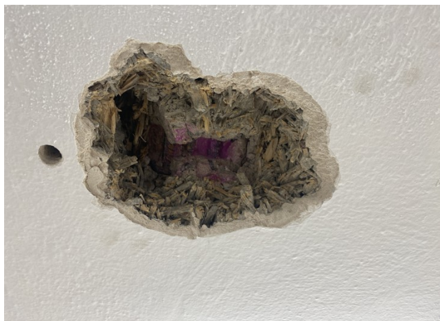
foto/5/ Pohled na provedenou sekanou sondu ŽB žebírka T2
