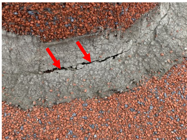
foto/53/ Pohled na netěsnost v místě opravy kruhového prostupu
