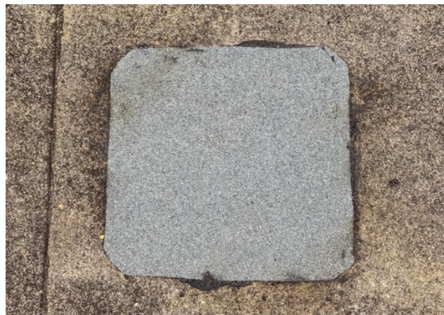
foto/14/ Pohled na zapravenou sondu S1
