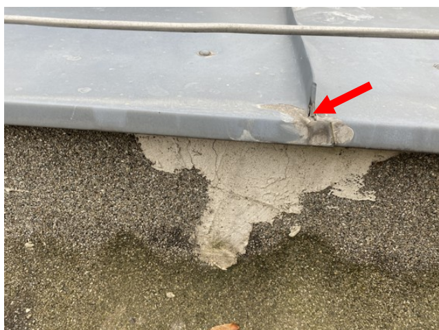
foto/45/ Pohled na otevřený falcový spoj oplechování (utěsněn tmelem)
