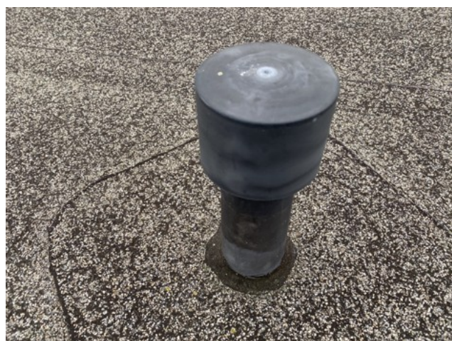
foto/50/ Pohled na systémovou tvarovku odvětrání horního pláště
