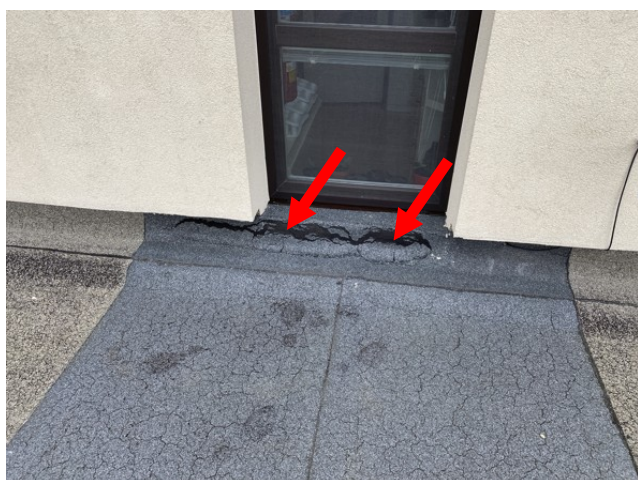
foto/39/ Pohled na ukončení hydroizolace v místě dveří krajního pavilonu (trhliny v asfaltové směsi)
