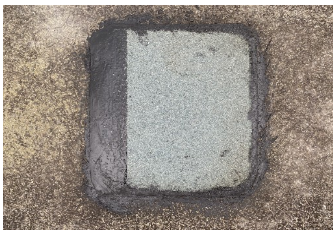
foto/22/ Pohled na zapravenou sondu S3
