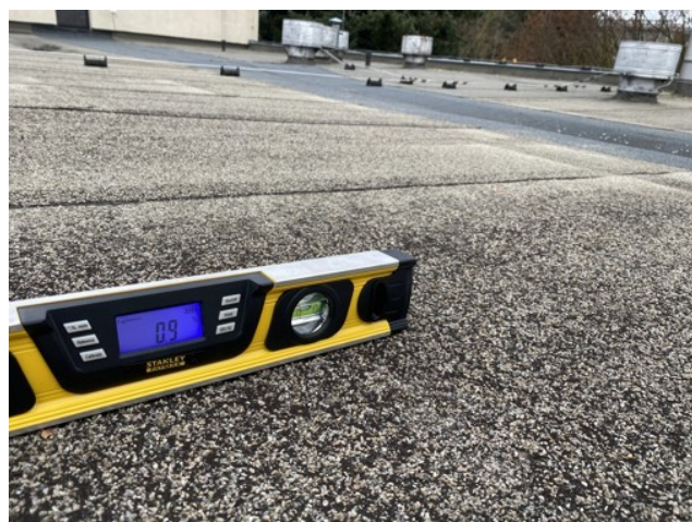
foto/28/ Pohled na změřený sklon v ploše střechy (změřeno cca 1,6%)
