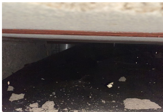
foto/17/ Pohled calofrigové panely uložené mezi ocelovými „T“ profily v místě provedené sondy S2
