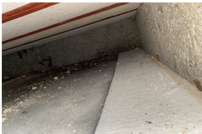
foto/25/ Pohled calofrigové panelů uložené mezi ocelovými „T“ profily v místě provedené sondy S4
