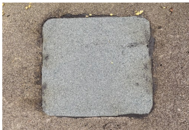
foto/18/ Pohled na zapravenou sondu S2
