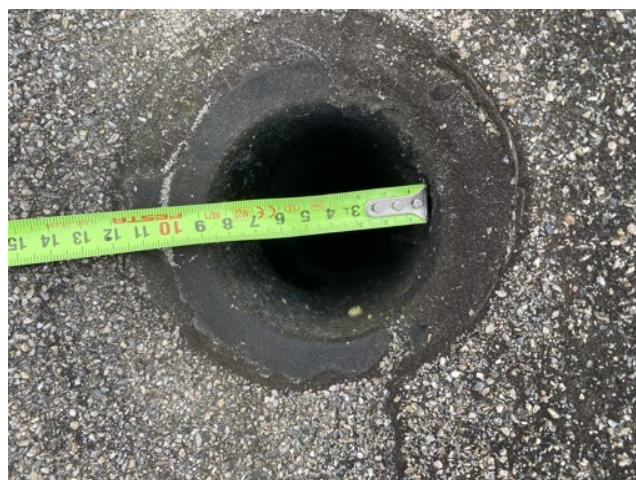
foto/56/ Pohled na průměr střešního vtoku (cca 85 mm)
