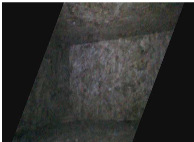
foto/3/ Pohled na ztracené bednění Velox v dutině v blízkosti sekané sondy žebírka T1 (foto z inspekční kamery)
