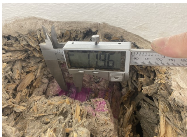
foto/7/ Pohled na průměr krajní hlavní výztuže v místě sekané sondy ŽB žebírka T2 (cca 12 mm)
