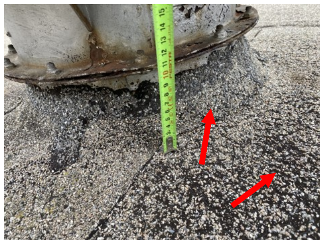
foto/48/ Pohled na opravování a vytažení HI vrstvy na zdegradované větrací šachtu (vytažení HI cca 90 mm)
