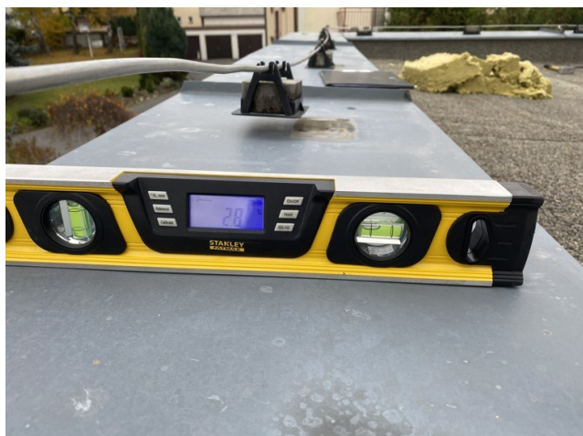
foto/35/ Pohled na změřený sklon atiky (změřeno cca 2,8 %)
