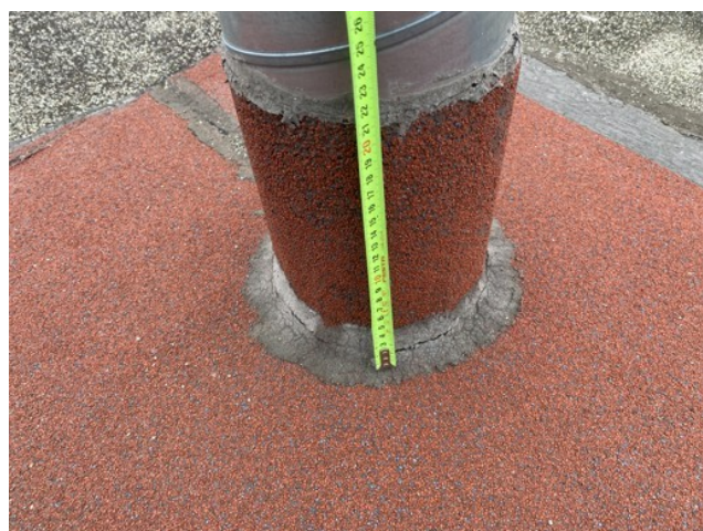
foto/52/ Pohled na opravování a vytažení HI vrstvy na větrací potrubí (vytažení HI cca 210 mm, absence stahovací objímky)
