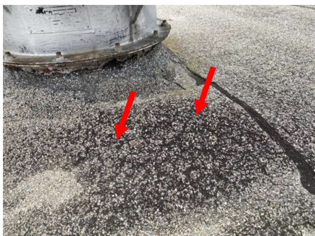
foto/49/ Pohled na vyboulení HI (uzavřené vlhkosti) v blízkosti zdegradované větrací šachty
