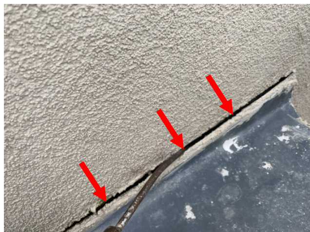
foto/42/ Pohled na netěsnosti v místě opravení napojení oplechování atik na přiléhající stěny krajního pavilonu
