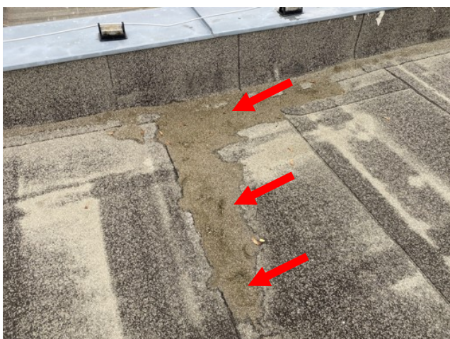
foto/31/ Pohled na vymytý a vyplavený břidličný posyp hlavní hydroizolační vrstvy
