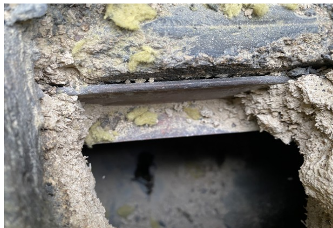
foto/16/ Pohled na ocelové „T“ profily v místě provedené sondy S2
