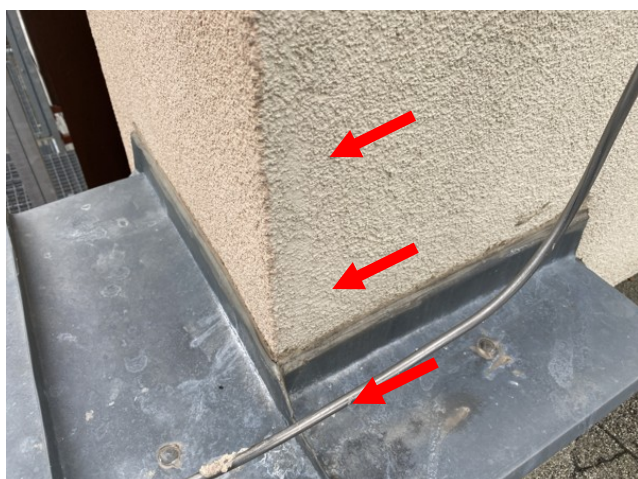
foto/43/ Pohled na opravení napojení oplechování atik na přiléhající stěny krajního pavilonu za pomoci tmele
