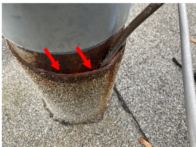
foto/51/ Pohled na netěsnost v místě opravování kruhového prostupu (absence stahovací objímky a zdegradované potrubí)
