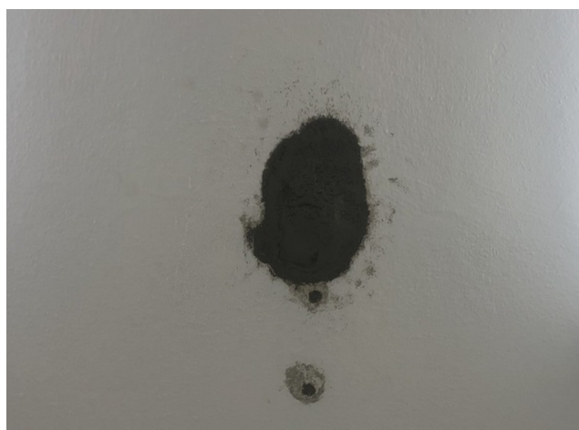
foto/8/ Pohled na zapravenou sekanou sondu žebírka T2
