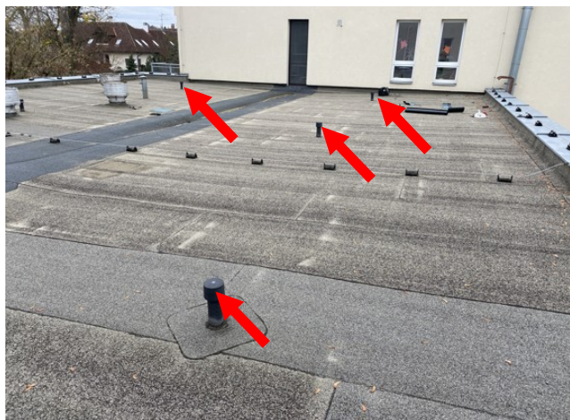
foto/9/ Pohled na předmětnou střechu prostředního pavilonu a větrací komínky horního pláště
