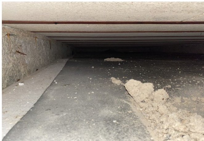
foto/20/ Pohled calofrigové panely uložené mezi ocelovými „T“ profily v místě provedené sondy S3
