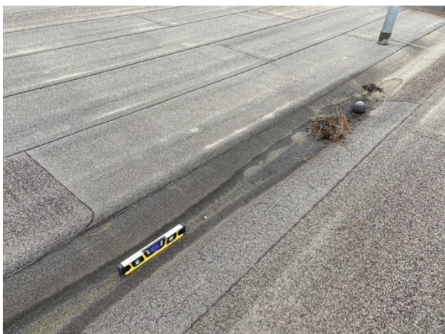
foto/29/ Pohled na místo měření sklonu (v úžlabí střechy)
