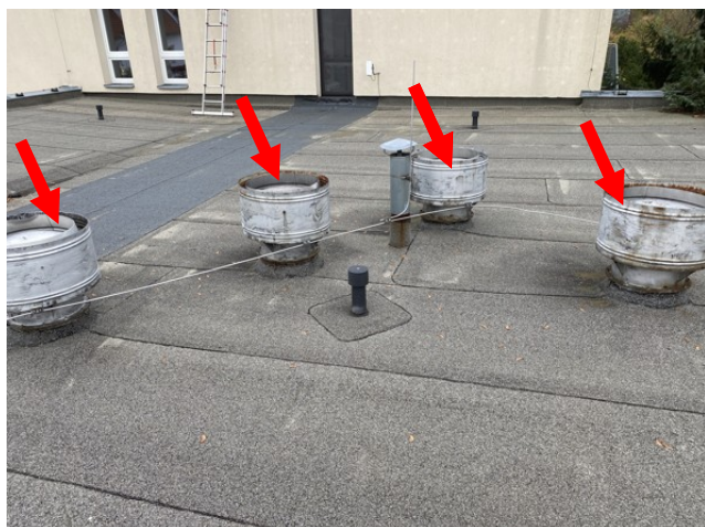
foto/47/ Pohled na zdegradované větrací šachty vlivem koroze
