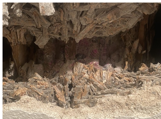
foto/2/ Pohled na obnaženou výztuž v místě sekané sondy žebírka T1 a na míru karbonatce (mírná karbonatce)
