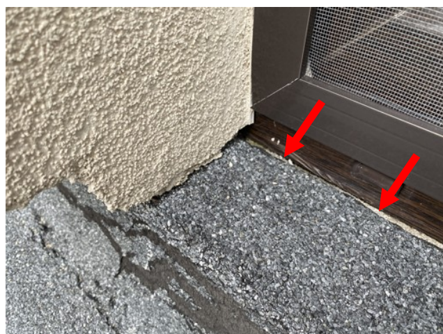
foto/40/ Detailnější pohled na ukončení hydroizolace v místě dveří krajního pavilonu a netěsnosti
