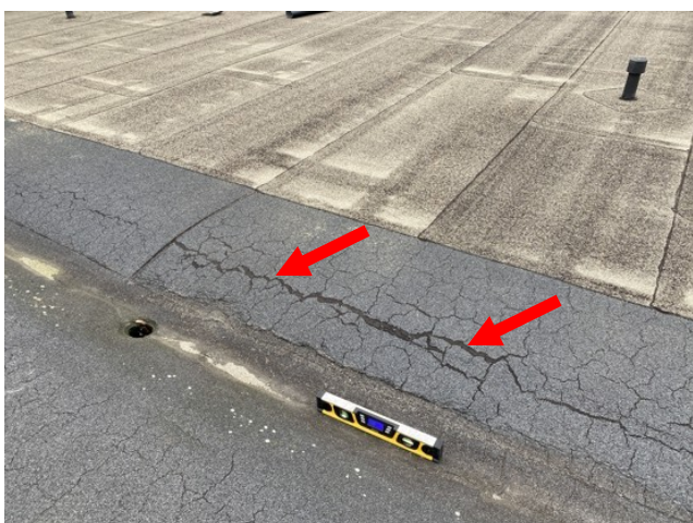
foto/33/ Pohled na trhliny v asfaltové směsi
