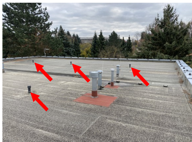
foto/12/ Pohled na předmětnou střechu pavilonu B a větrací komínky horního pláště
