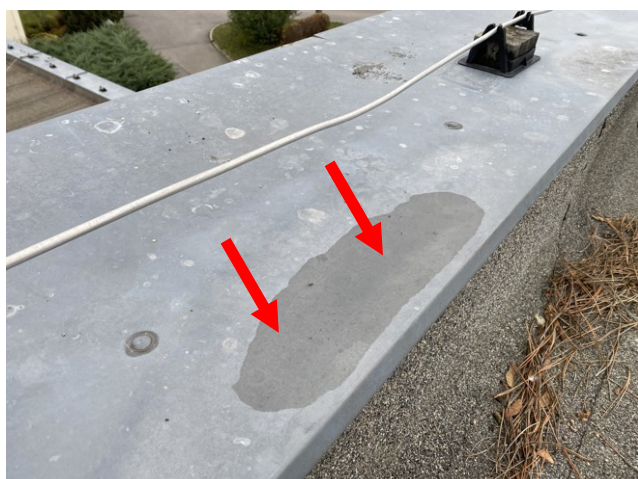
foto/37/ Pohled na kaluž v místě zdeformovaného oplechování
