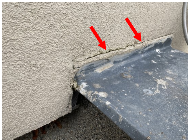
foto/41/ Pohled na netěsnosti v místě opravení napojení oplechování atik na přiléhající stěny krajního pavilonu
