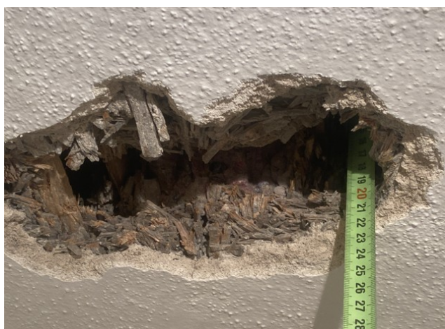
foto/1/ Pohled na provedenou sekanou sondu ŽB žebírka T1
