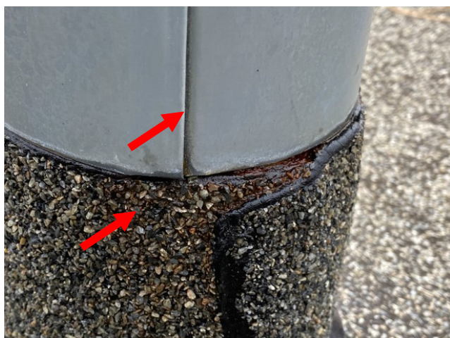
foto/55/ Pohled na opravu a stékající kondenzát po povrchu větracího potrubí
