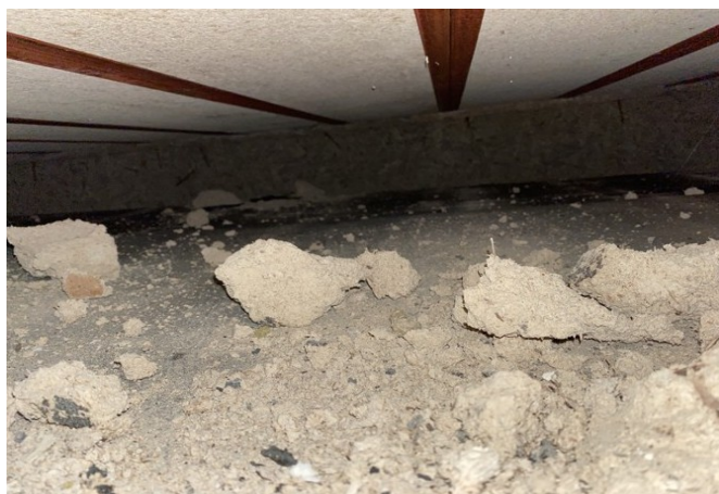
foto/24/ Pohled calofrigové panely uložené mezi ocelovými „T“ profily v místě provedené sondy S4
