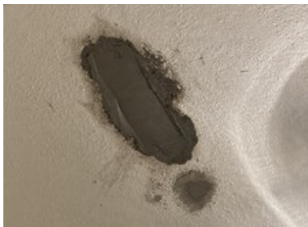
foto/4/ Pohled na zapravenou sekanou sondu žebírka T1
