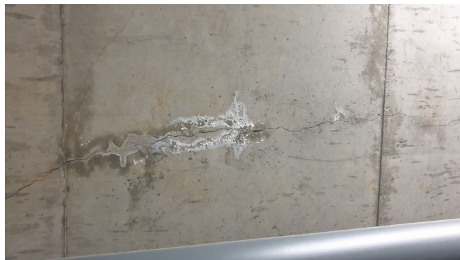
foto /14/ Detail trhlin ve stropní konstrukci
