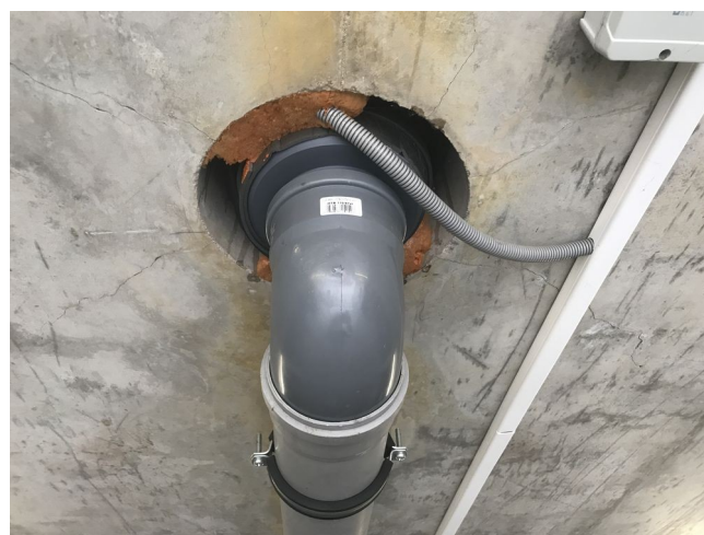
foto /10/ Prostup střešní konstrukcí + potrubí DN 110
