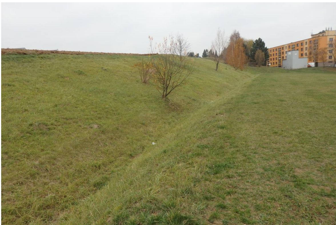
Stávající zatravněný příkop pod lokalitou nestačí přívalovou vodu pojmout a zaplavují se bytovky.
